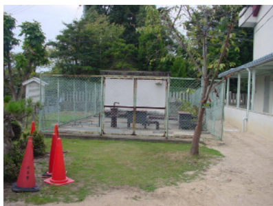
(撤去前の浄化槽)
